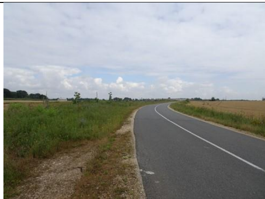
Photographie de l'état initial
