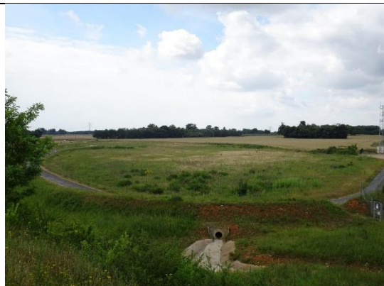
Photographie de l'état initial
