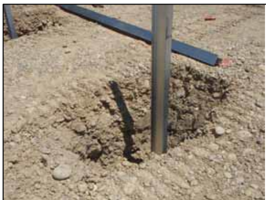
Figure 9 : Types de fondation - pieux battus
