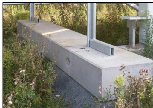
Figure 10 : Types de fondation - semelle béton
